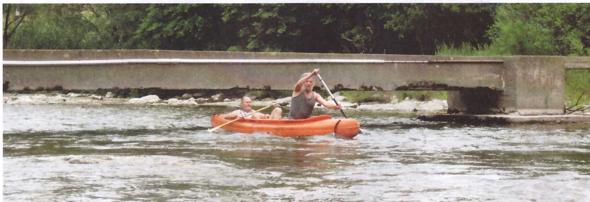
Lod' duchů právě projela pod mostem
